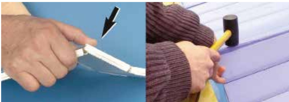
Abbildung 44 – Einklemmen der Lamellen
