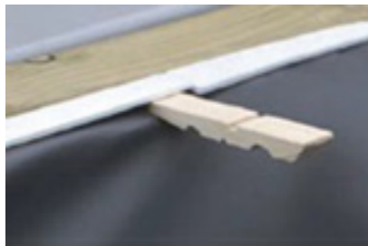
Abbildung 28 – Verklebung der Folienauskleidung mithilfe der halben Wäscheklammern
