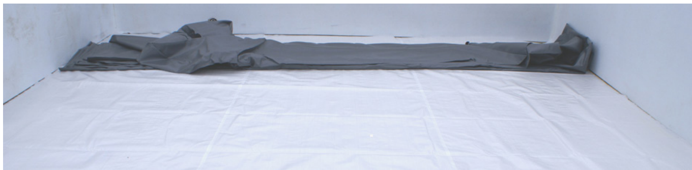
Abbildung 27 – Entfalten der Folienauskleidung
