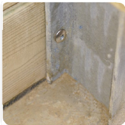
Abbildung 9 – Verkantung der Bohlen auf den Streben
