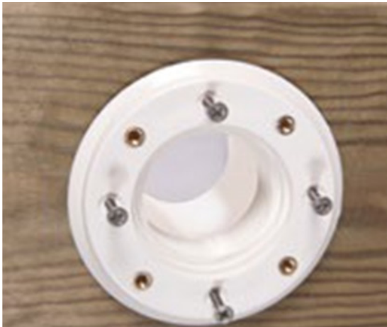
Abbildung 24 – Montage der Wanddurchführung für Einlaufdüse
