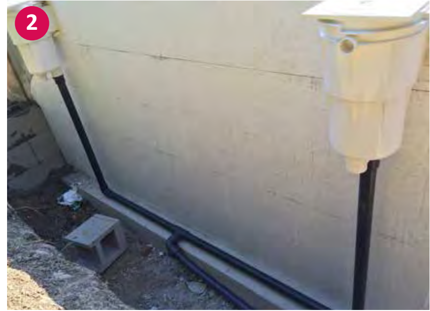
▲ Verrohrung von 2 Skimmer
