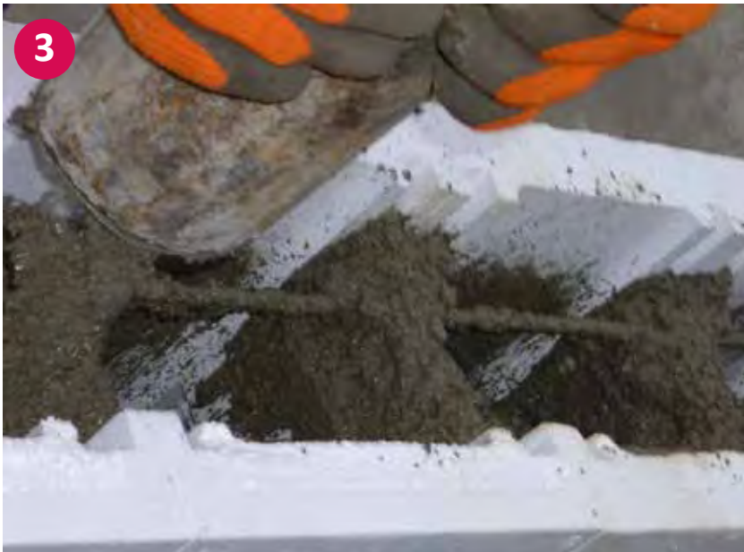
▲ Detailsicht: Ausfüllen der Styroporstein mit dem Beton
