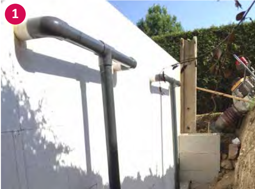
▲ Verrohrung von 4-Düsen
