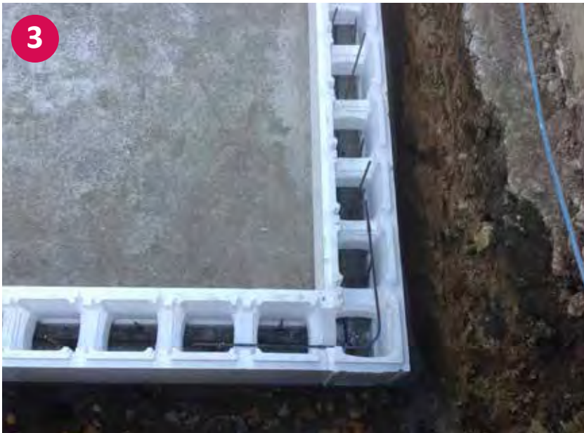
▲ Detailbild einer Eckverbindung samt Eisenarmierung
