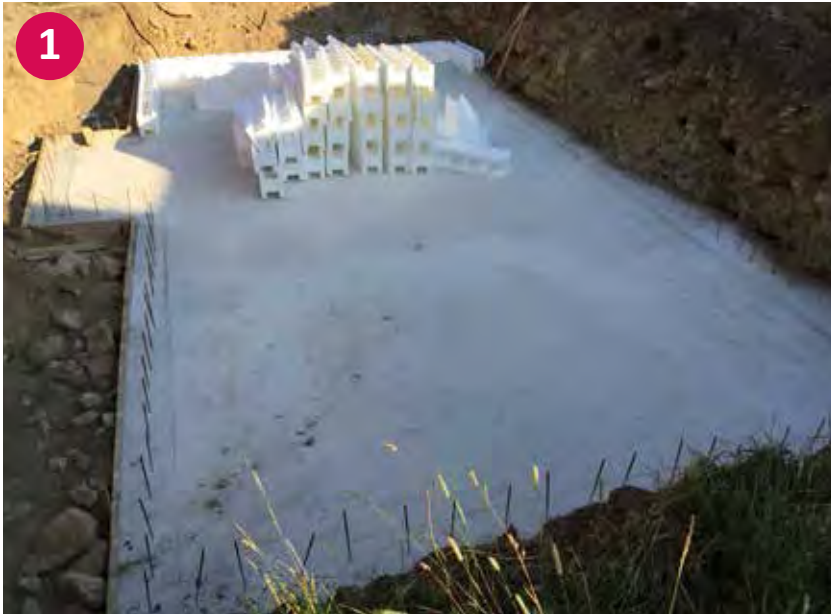
▲ Fertig ausgehärtete Bodenplatte
