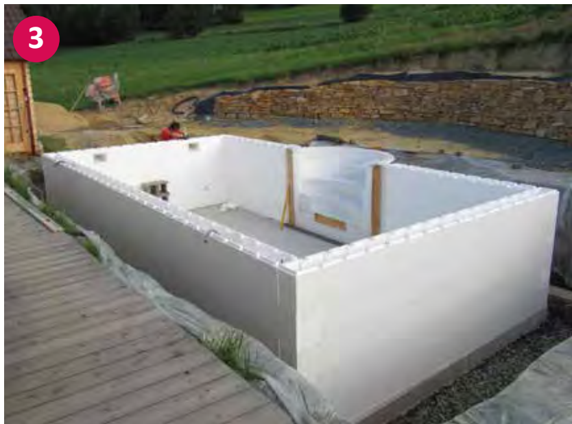
▲ Aufgestelltes Styroporstein Becken mit Römertreppe – ohne Betonfüllung
