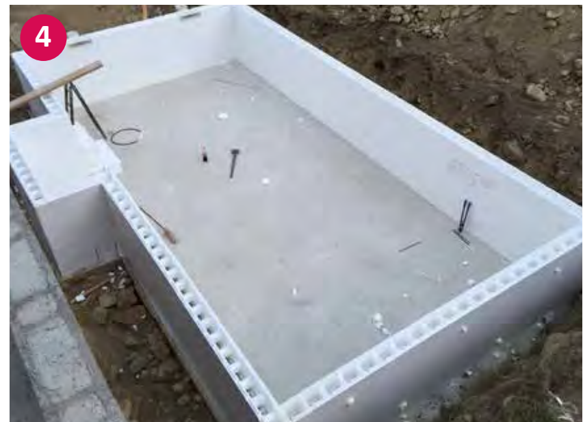
▲ Fertig aufgestelltes Styropor Becken – ohne Betonfüllung
