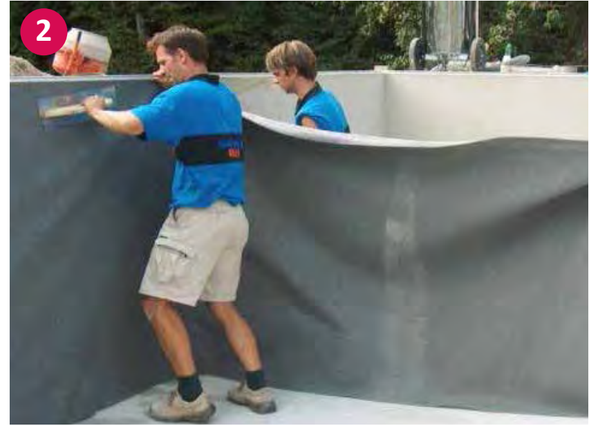
▲ Punktuelle Befestigung der Vliestrennlage mittels Styroporkleber
