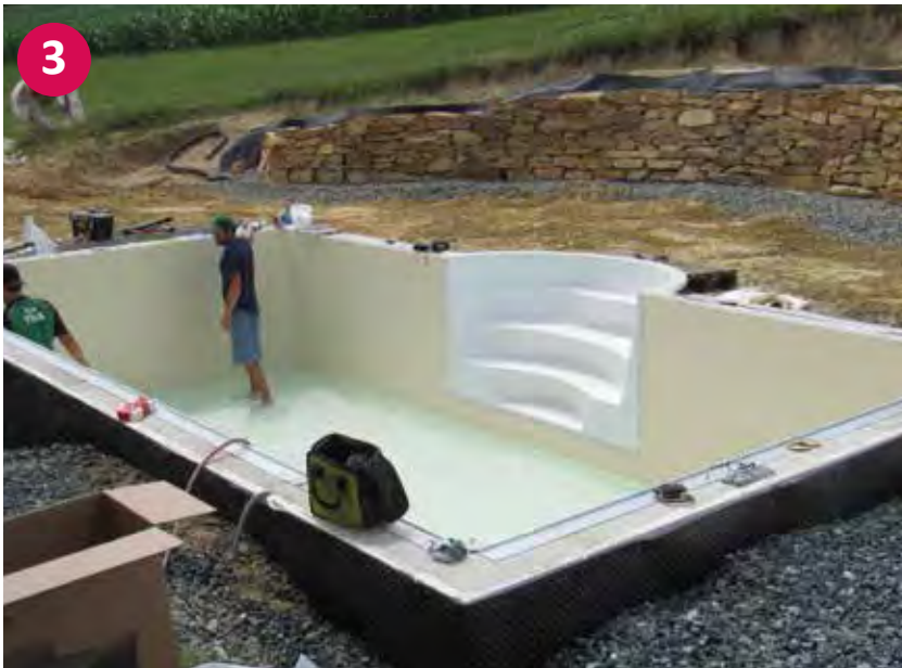
▲ Einhängen des Foliensacks und Anflanschen der Einbauteile
