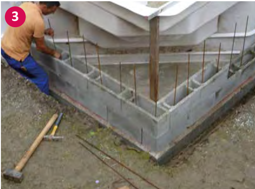
▲ Untermauerung der Ecktreppe
