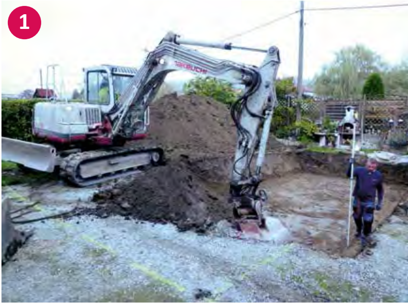
▲ Aushub der Baugrube
