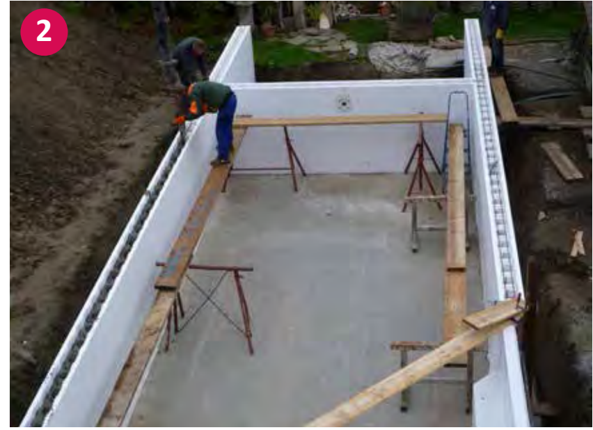
▲ Ausfüllen der Styroporstein mit dem Beton
