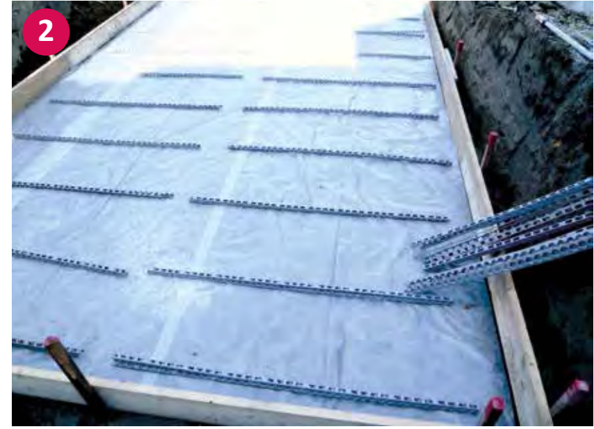
▲ Abschallung der Bodenplatte
