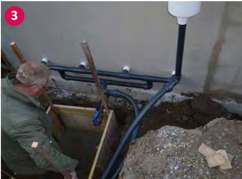
▲ Verrohrung von Düsen, Skimmer und Bodenablauf
