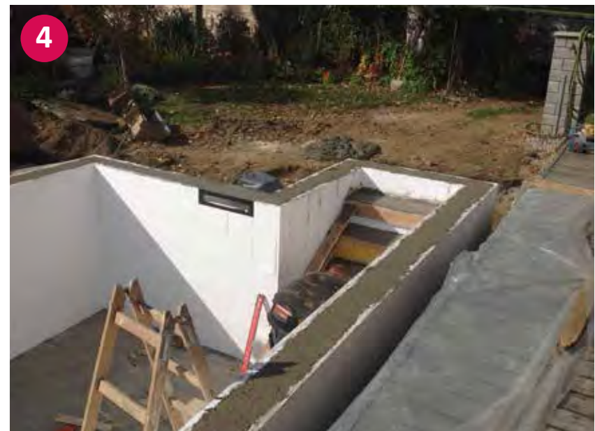
▲ Fertig ausgefülltes Styroporsteinbecken mit Beton
