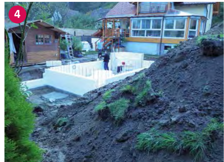
▲ Aufgestelltes Styroporstein Becken mit Ecktreppe – ohne Betonfüllung Ecktreppe
