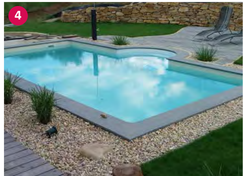
▲ Fertiges Styroporsteinbecken mit Römertreppe
