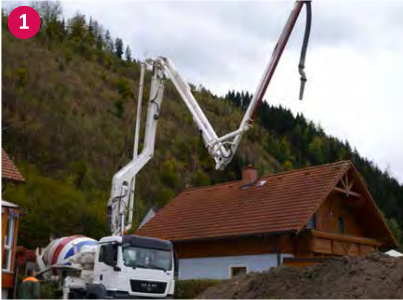
▲ Betonwagen mit Betonpumpe und Fallbremse
