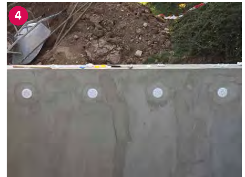
▲ Wichtig: Abdrücken der Rohrleitungen!
