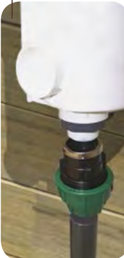
Starres abfallendes Rohr unter dem Skimmer
