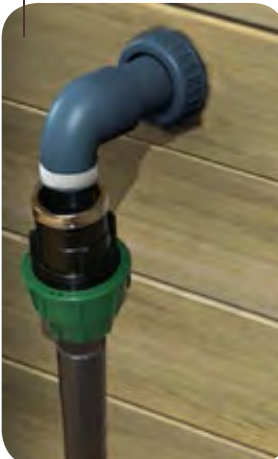
Starres abfallendes Rohr unter dem Reinigeranschluss
