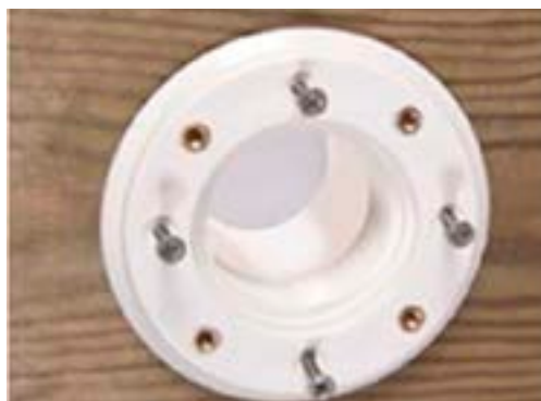
Abbildung 15 – Montage der Wanddurchführungen
