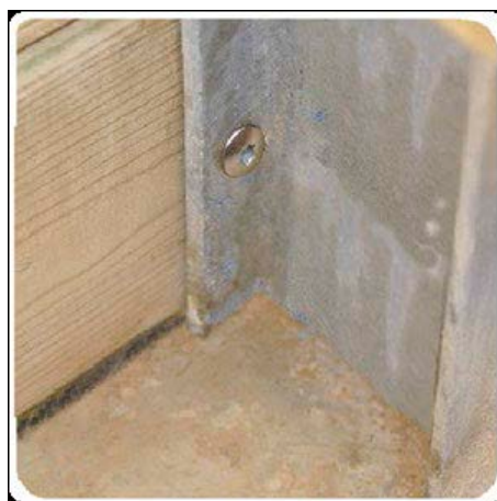
Abbildung 8 – Verschraubung der Bohlen auf den Streben
