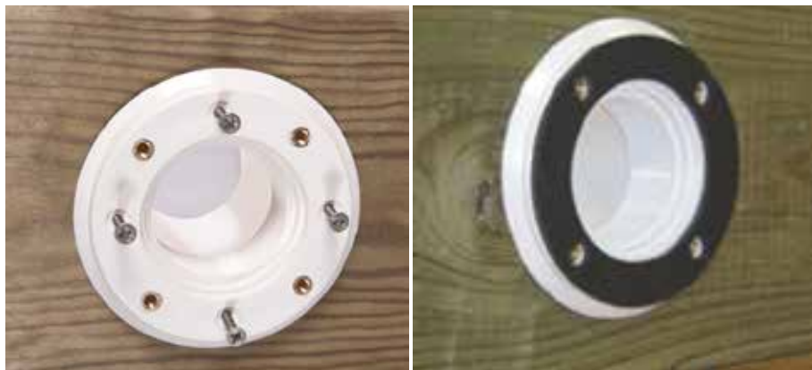
Abbildung 24 – Montage der Ausstoßdüse und seiner Dichtung
