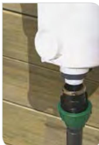
Abbildung 44 – Anschluss des Skimmers
