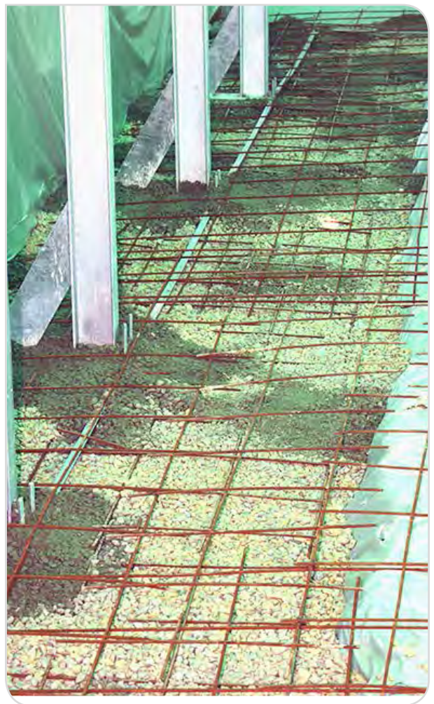
Abbildung 10 – Giessen des Betonplatte (b)
