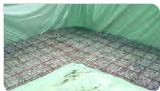
Abbildung 3 – Boden des Aushubs
