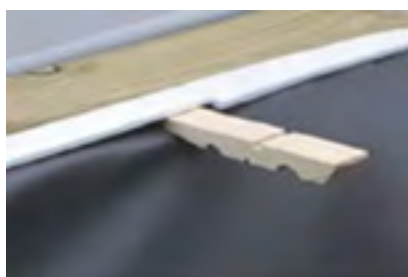
Abbildung 28 – Verklebung der Folienauskleidung mithilfe der halben Wäscheklammern
