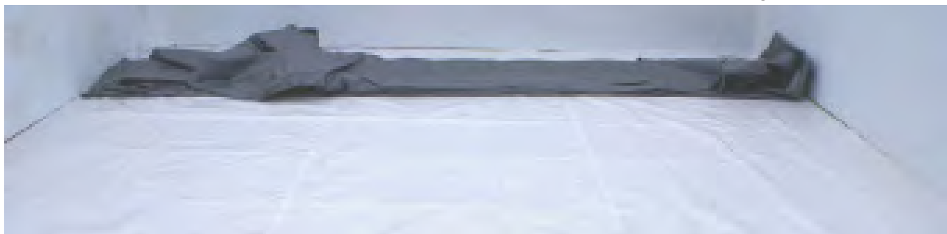
Abbildung 27 – Entfalten der Folienauskleidung
