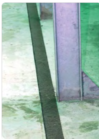
Abbildung 7 – Schaffung der Bitumenstreifen
