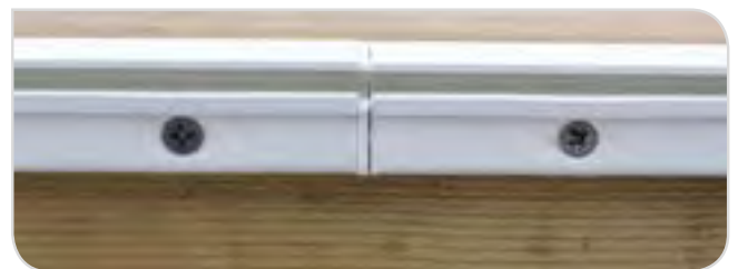
Abbildung 28 – Klemmprofil bündig mit der Beckenoberkante abschließen
